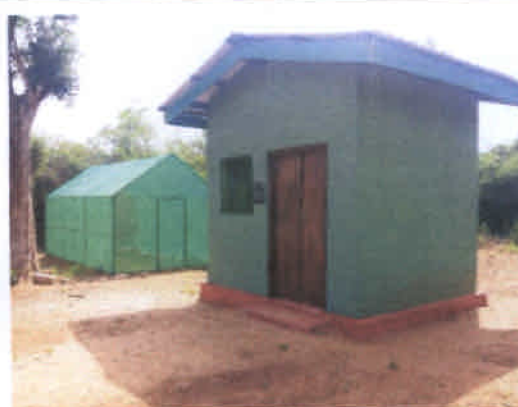
タッチャダンバン地区苗生産センター建屋 およびグリーンハウス
