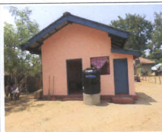
ムハマライ地区製粉センター建屋（後）
