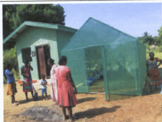
マナカンドル地区苗生産センター建屋および グリーンハウス
