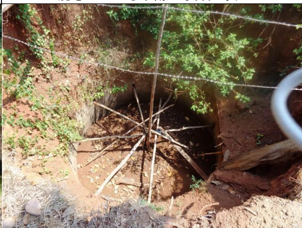
ムライティブ県オッディスタン郡 Thachadamban 地区 （住民によって補修されている途中の家庭用井戸）
