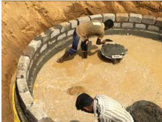
土壌の柔らかい地区では井戸を沈めながら作る ステップダウン方式を採用 (タンバハمام地区/2016年8月)
