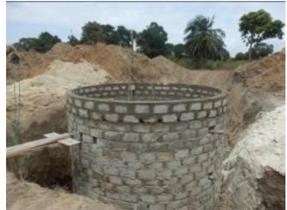
石作業が完了した井戸 (アナイウィランサン地区/2016年8月)
