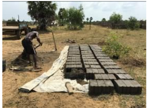
井戸に使用するコンクリートブロックの作成 (タンバハママム地区/2016年8月)
