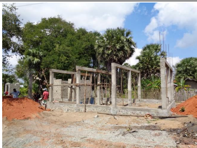
カルナドゥカーニ村のセリ場建設現場（2015年2月）
