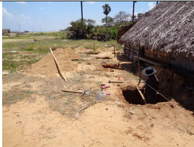
カラパドゥ・ノース村のセリ場建設現場（2015年2月）
