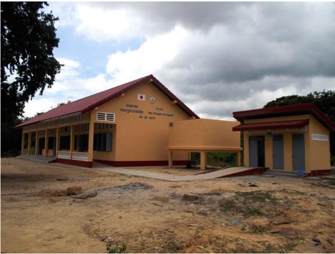
クランリウ小学校新校舎、給水タンク、トイレ
