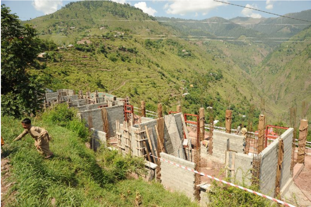
GPS、GMS、GHS Daban 建設（2015 年 6 月）
