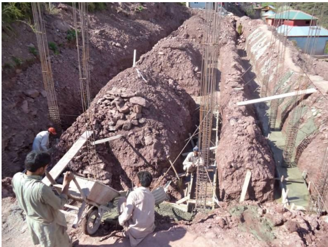
GMS Daban 建設（2015 年 3 月）
