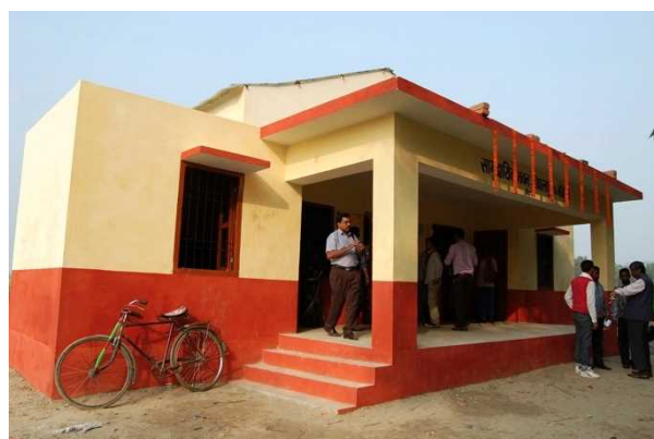
コミュニティセンター (ゴパールプル/Goparapur 村、第 2 期建設)
