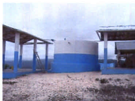
十分な雨水を確保するために建設した屋根
