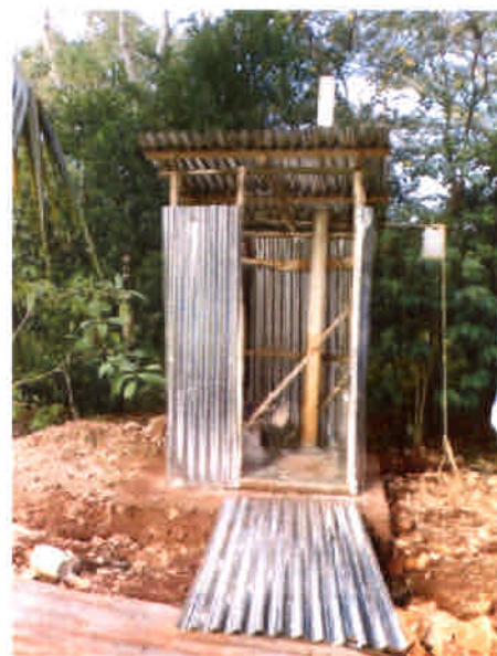
世帯トイレ土台・柱設置
