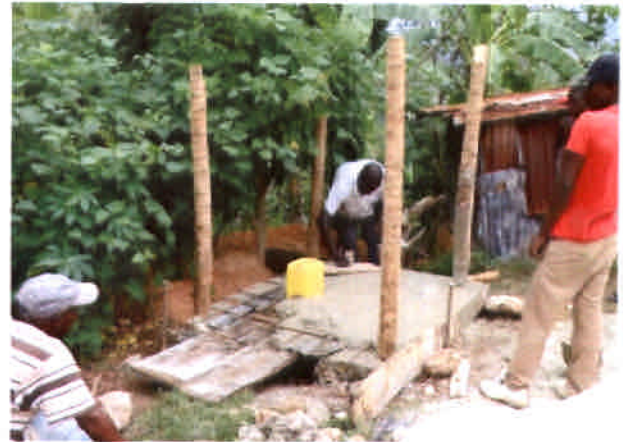
世帯トイレ土台・柱設置
