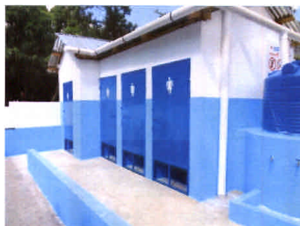
建設した衛生設備
