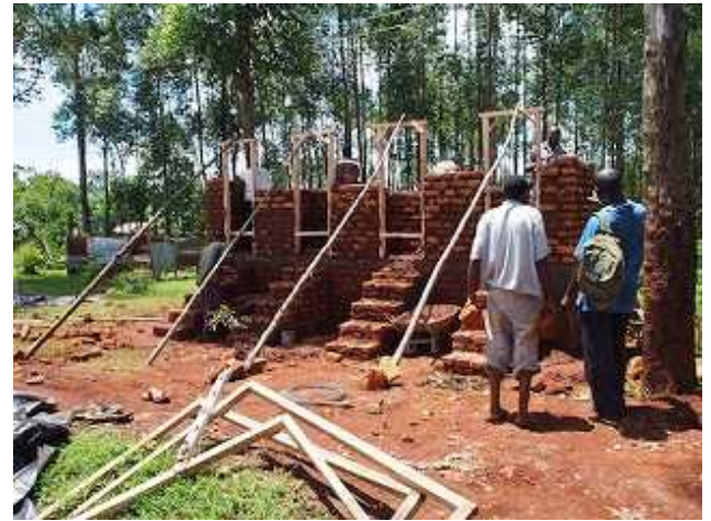
【写真2】認定ビルダーと当会の現地スタッフ（右）が小学校でエコサントイレを建設する様子。（2016年4月）
