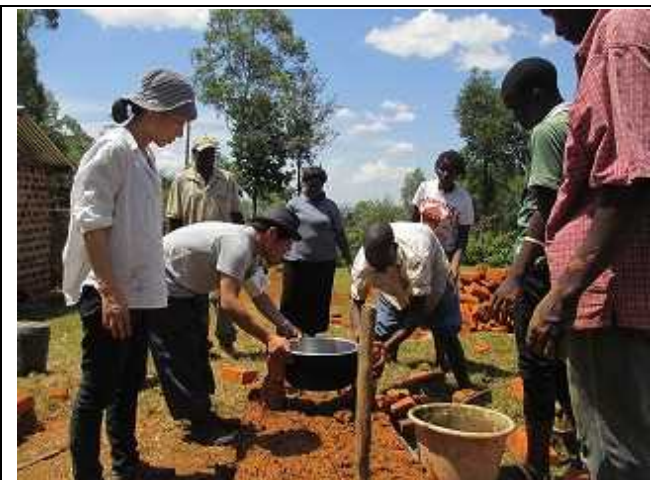
【写真 19】改良かまどのビルダー養成研修（実技）を行う江崎建築専門家（中央）と当会スタッフ（原田）。（2016年3月）
