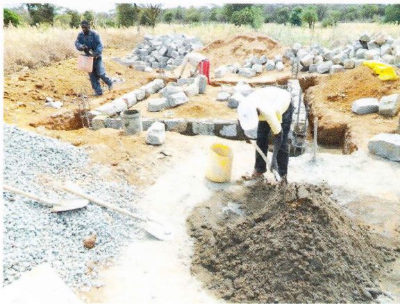
③キボウロケーションにおける給水所建設
