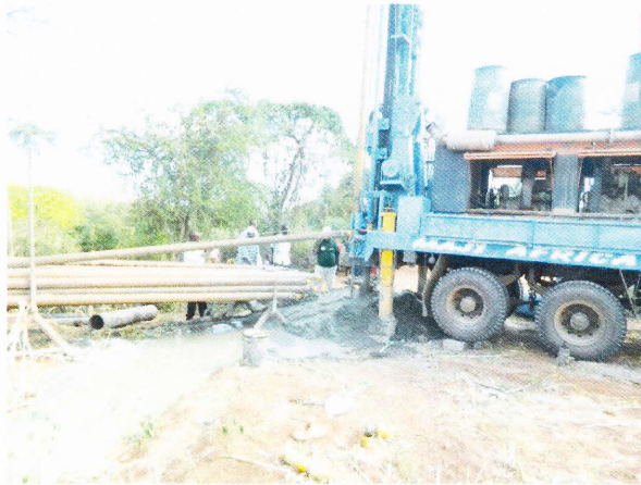
①キボウロケーションにおける深井戸掘削
