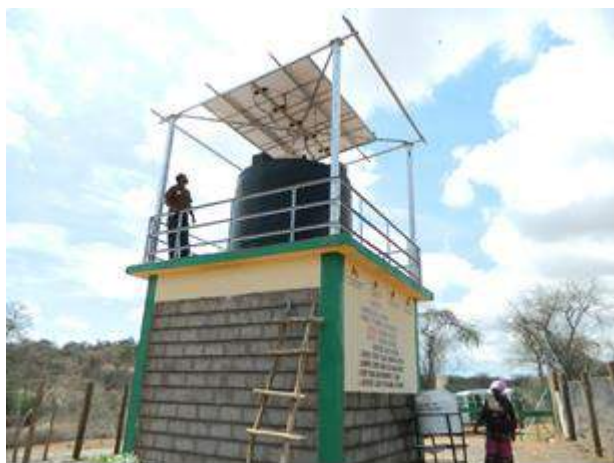
①カンザンズロケーションの給水所
