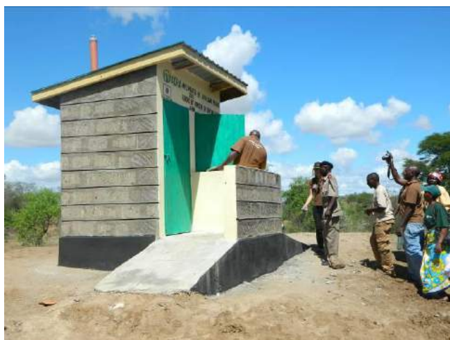
③カヴワニロケーションの給水所付近に建設したトイレ
