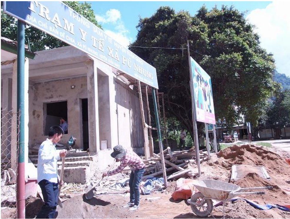
Pu Nhung コミュニティ保健センターの建設状況（左側の建物）
