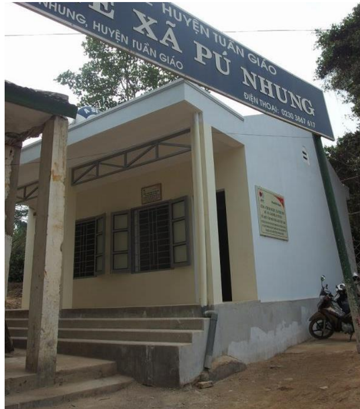
完成した Pu Nhung コミュニティ保健センター
