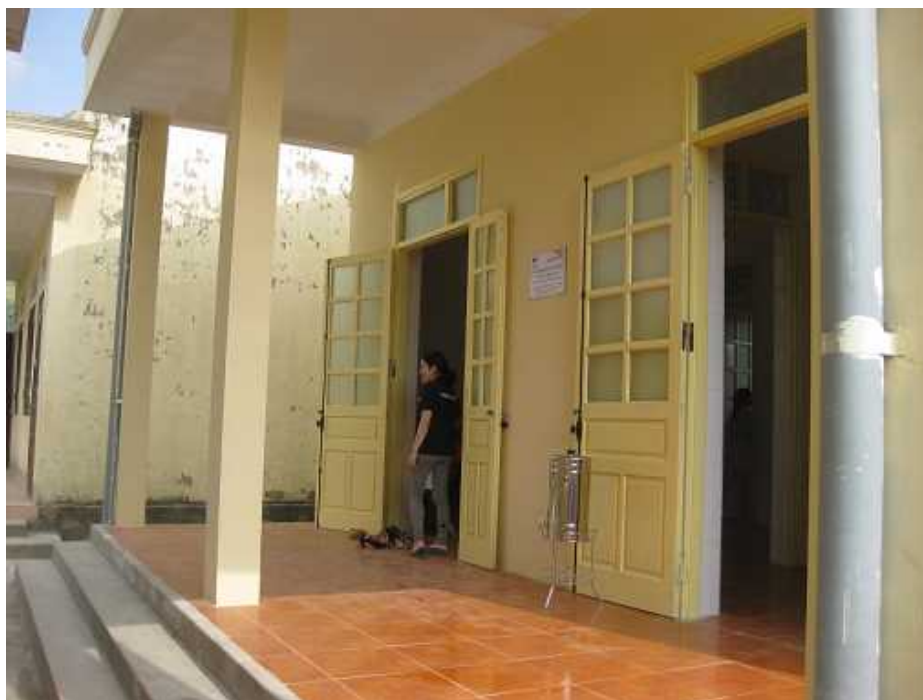
改築した Sa Long コミューン保健センターの産科室
