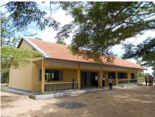
補修が終わった校舎
