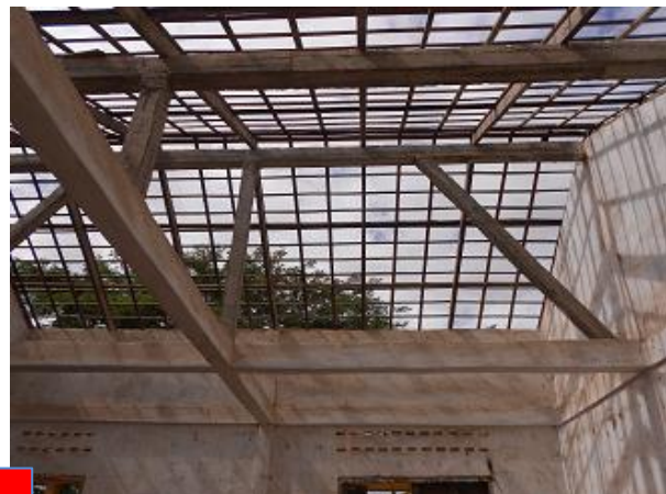
屋根の梁の様子（壊れている箇所を補修）
