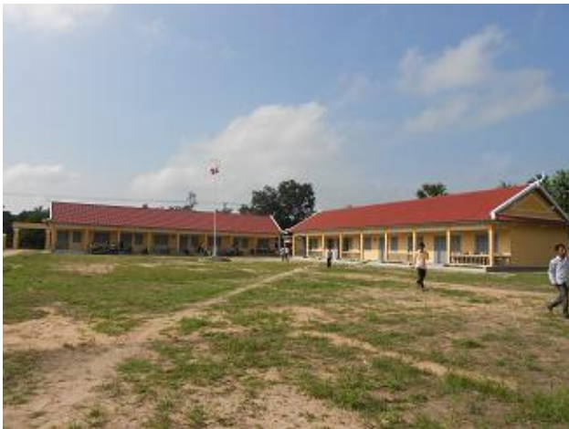
完成した校舎 2 棟
