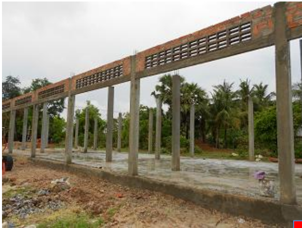
1 棟目 (西側) の様子
