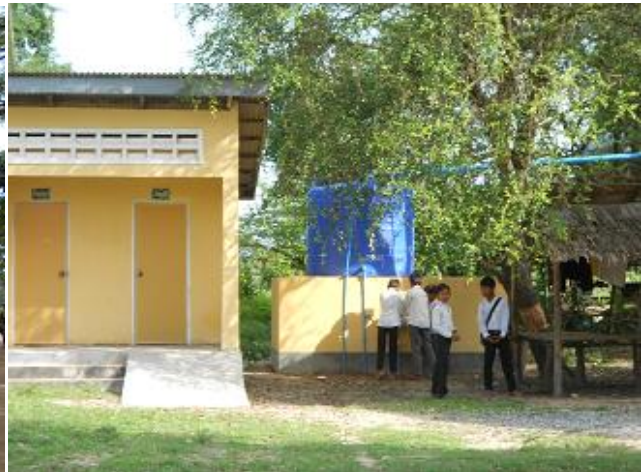
補修が終わったトイレと雨水の水槽
