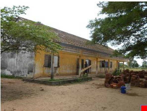
補修され始めた校舎
