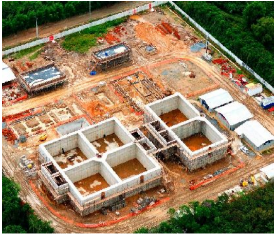
【建設中のモンガグアー下水処理場】
