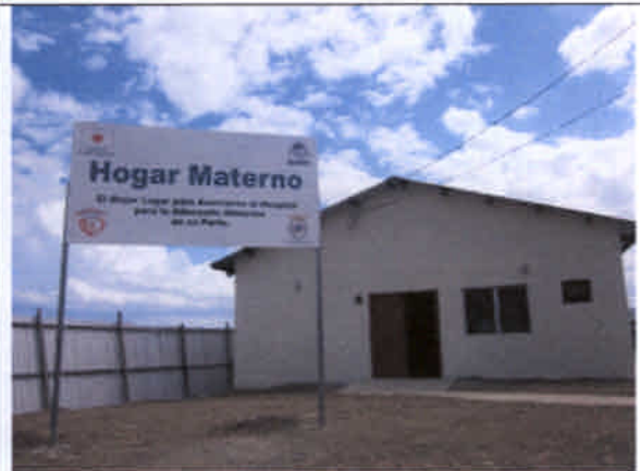
完成した妊婦の家の外観。
