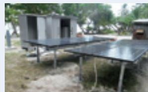
マヌス州の離島に10基設置された太陽光発電、海水淡水化設備（逆浸透膜法）の外観。水道・電力インフラが全くない場所でも、海水、地下水から浄化、WHO基準の飲料水をつくることができ、不安定で不衛生な雨水に依存しない生活が可能。（写真：双日株式会社）
