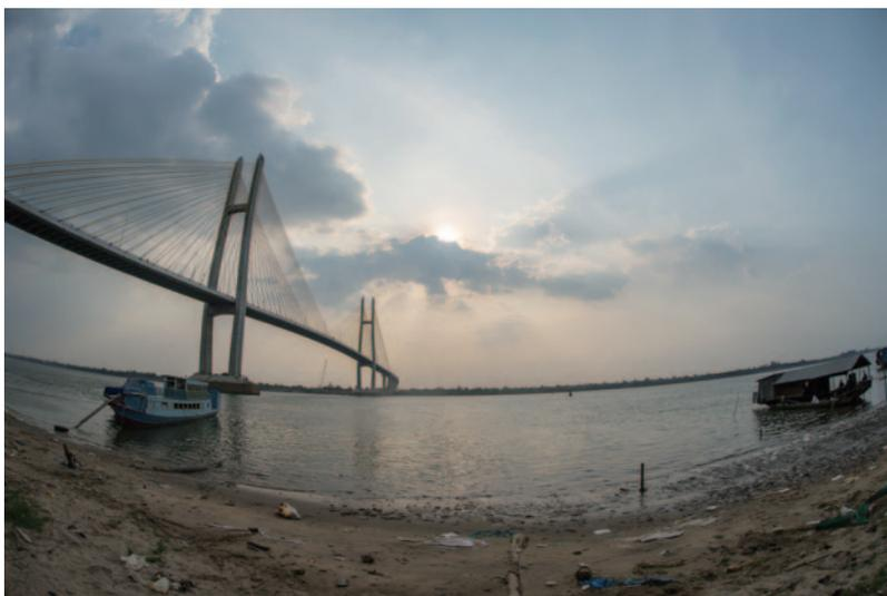
2015年4月に開通した、カンボジアのネアックルン橋（つばさ橋）。主橋梁640m、橋長2,215m、取り付け道路を合わせると、5,400mに及ぶ。メコン川を渡河するフェリーは、通過に1時間要していたが、橋の開通で5分程に短縮された。（写真：久野真一／JICA）
