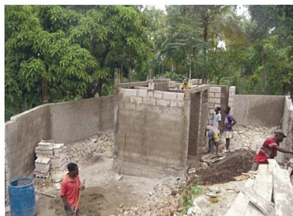
衛生設備建設の様子
