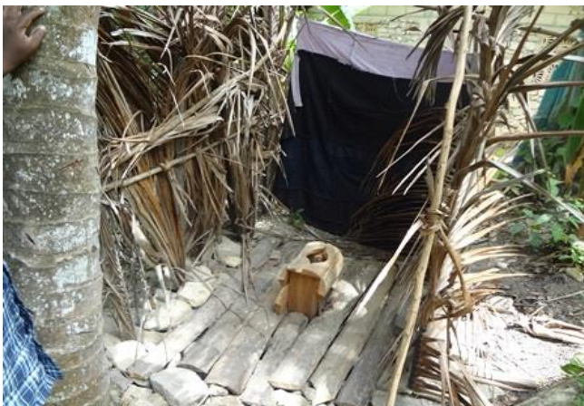
完成した世帯トイレ
