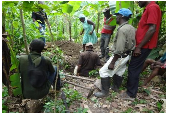
住民同士が協力し合い、トイレ建設が進められた
