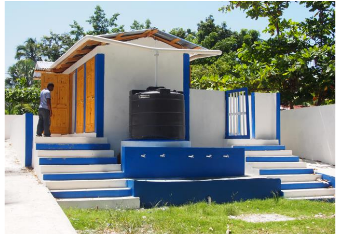
学校に建設された衛生設備
