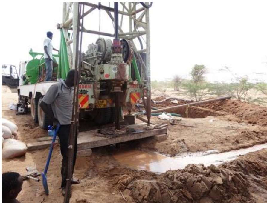
1. 井戸掘削作業の様子 (Jarirof 村) (撮影日：3月4日)
