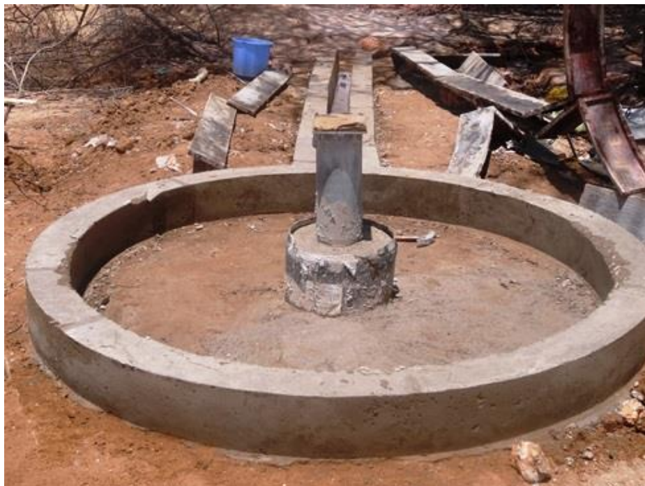
3. ハンドポンプ基礎工事 (Shabah 村) (撮影日：4月26日)
