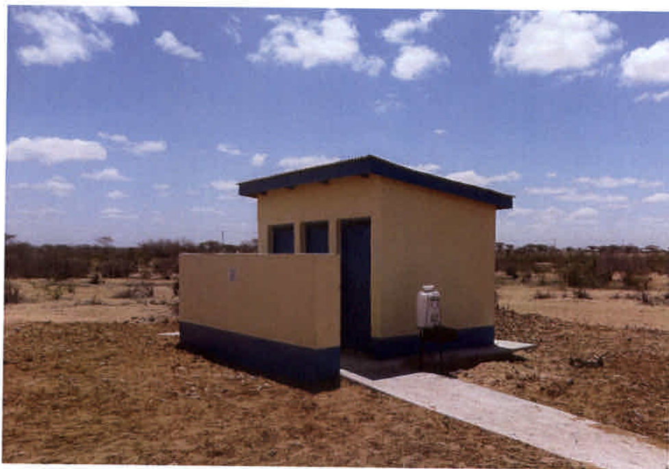
2. 完成したトイレ建屋と手洗い設備 (Shabah 村、2014 年 10 月 3 日撮影)
