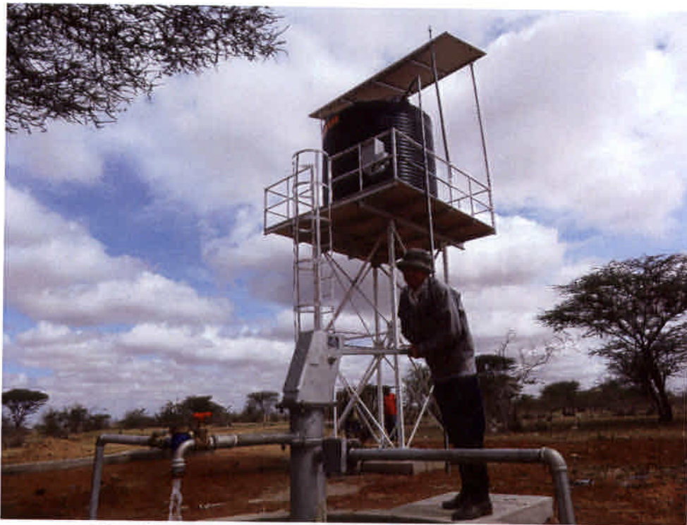
3. ハンドポンプの動作確認をする鈴木信駐在員（Shabah 村、2014 年 5 月 5 日撮影）
