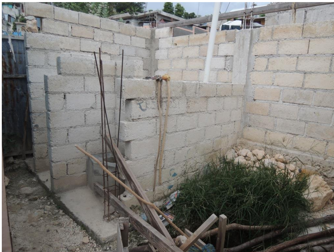
建設途中のトイレ
