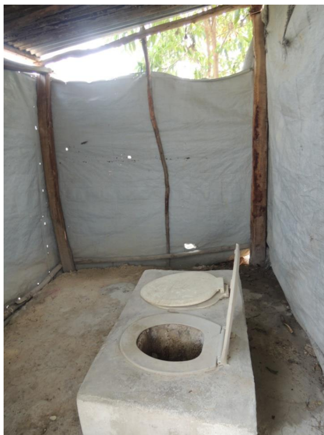
トイレ個室内部の様子、便座が2つ並んでいるが仕切りがない
