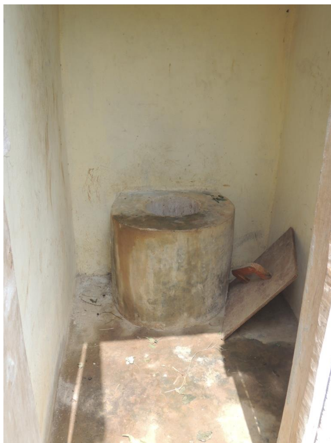
トイレの中の様子
