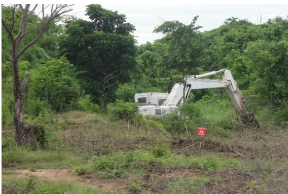
機械（BC）による灌木除去作業
