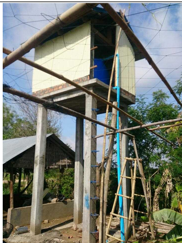
試験農場に完成した給水塔
