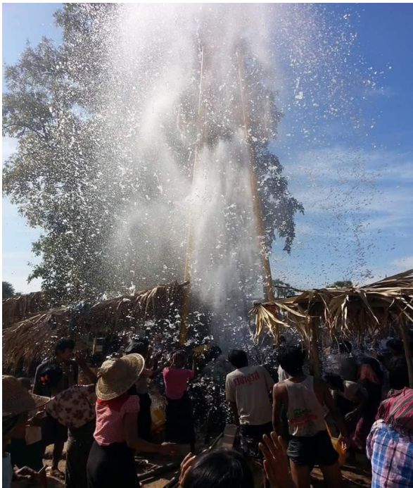
サンゴン村 井戸孔内洗浄（2月）
