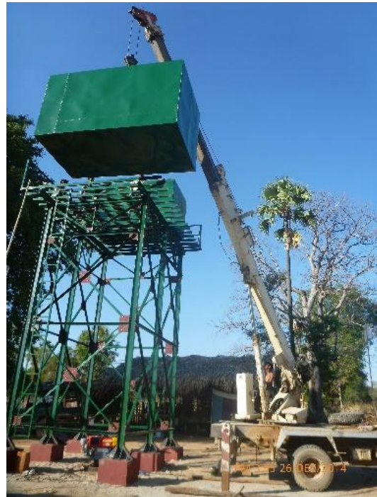
テルピンサカン村 高架型貯水タンクの建設（12月）
