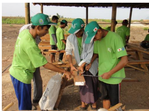
建設サイトでの実習（鉄筋加工）
