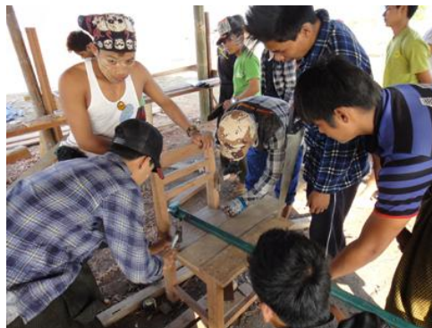
建設サイトでの実習（木工）
