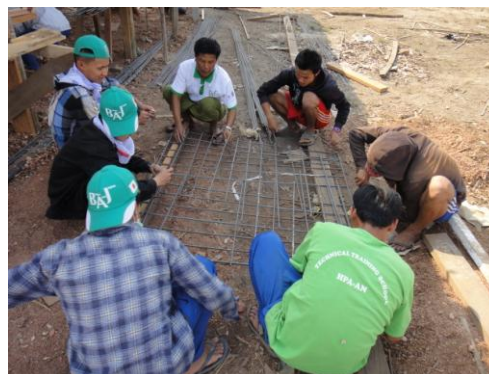
建設サイトでの実習（鉄筋加工）
