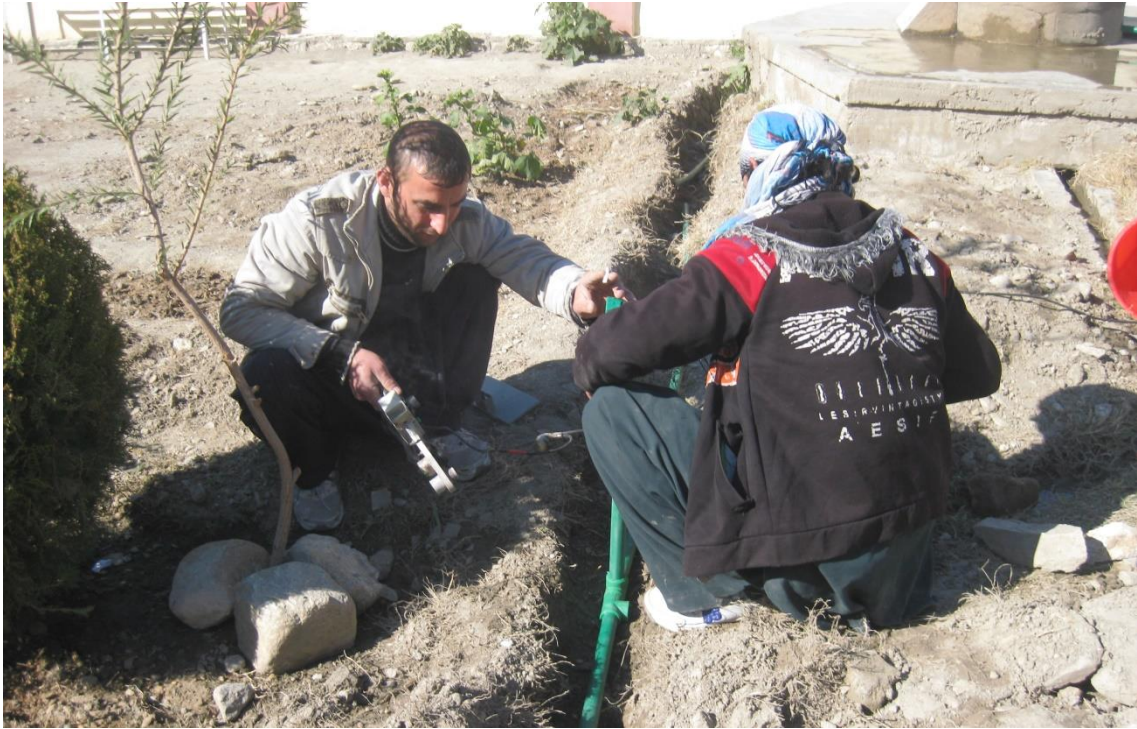
【 水道管の補修：クズ・カシュコート診療所】
