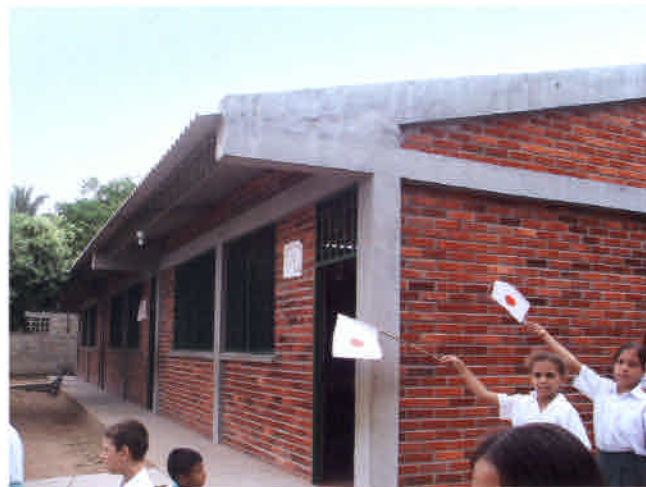
4. Vista exterior del colegio
