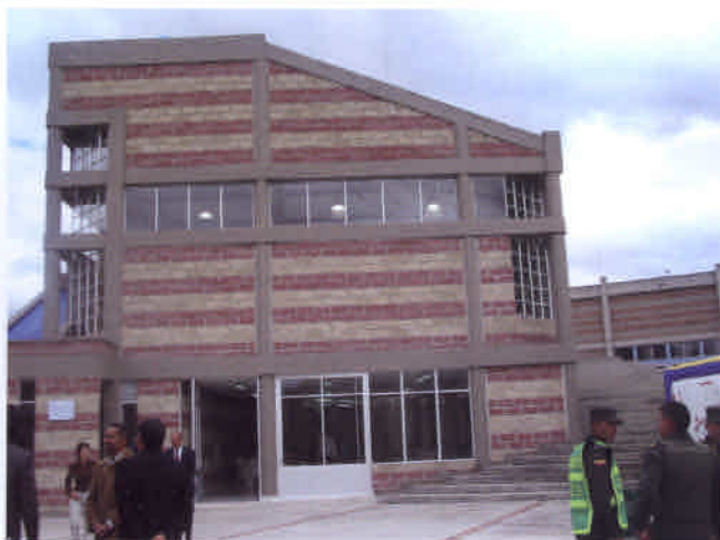
1. Construcción de una escuela de cocina
