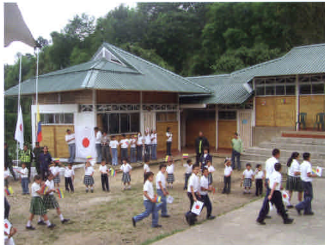
2. Vista exterior del colegio
