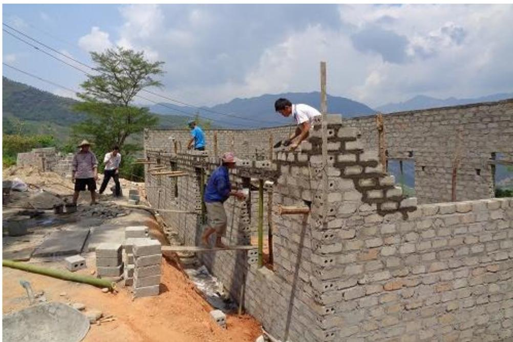
建設中のドアンケット小学校(ハザン省シンマン郡)。ハザン省は5～9月が雨季にあたるため、夏休みの時期を利用した建設は、雨の影響で遅れがちになる。そのため、9月の新学年開始に間に合うよう、現在急ピッチで建設を進めている
