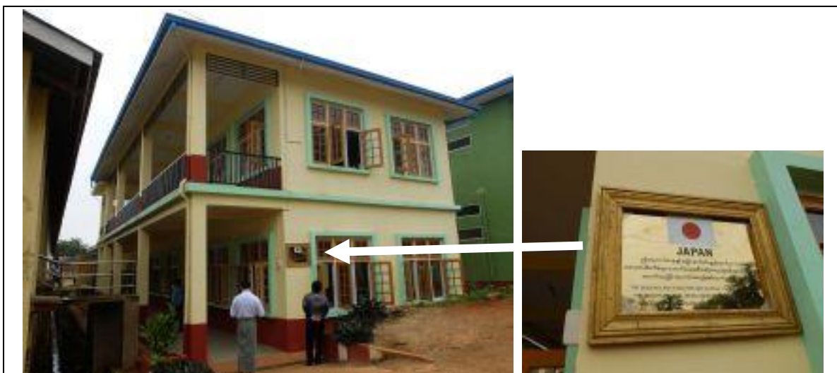
GGP で建設された感染病棟の外観
