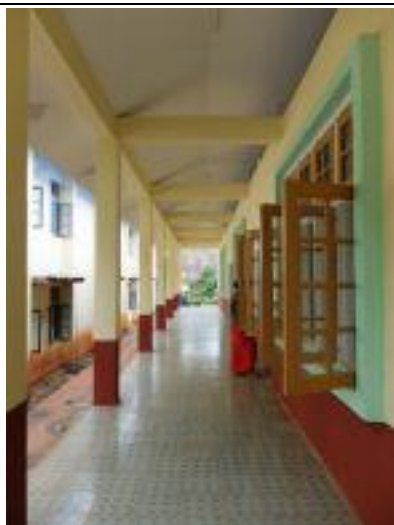
1 階の廊下部分 ↑
