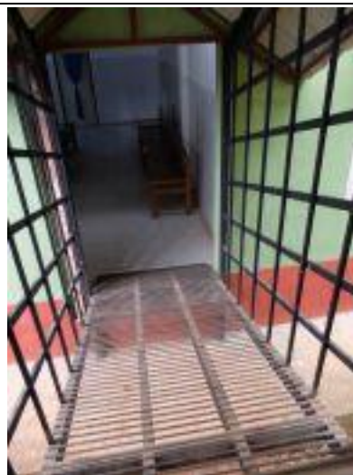
↑ 隣の一般病棟との間の渡り廊下
