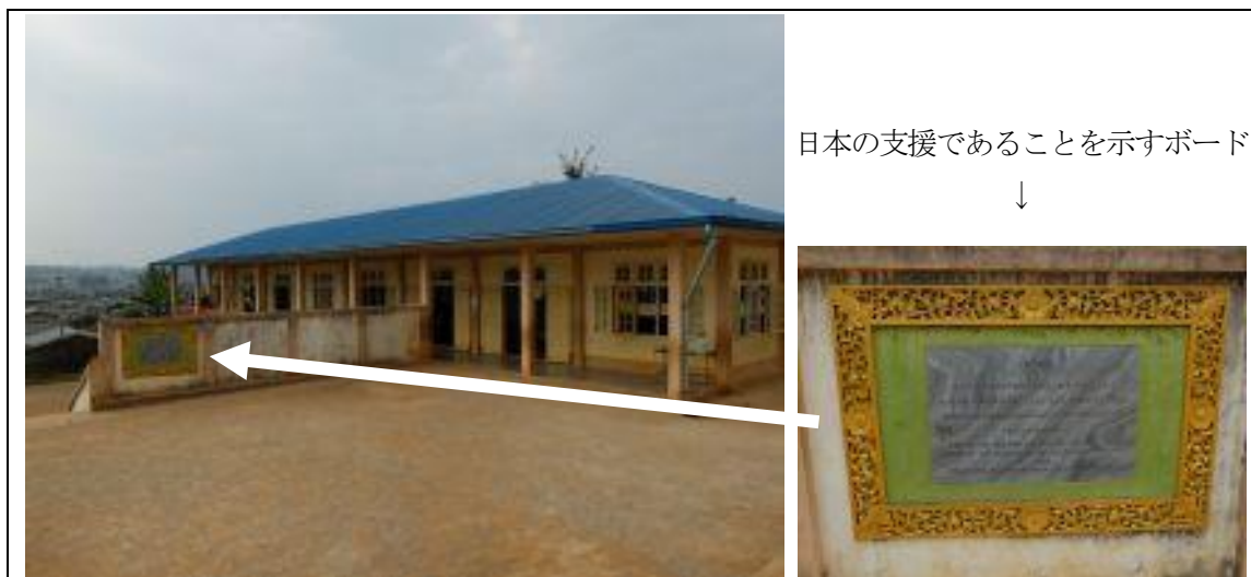
GGP で建設された校舎の外観（2 階部分と入口）
