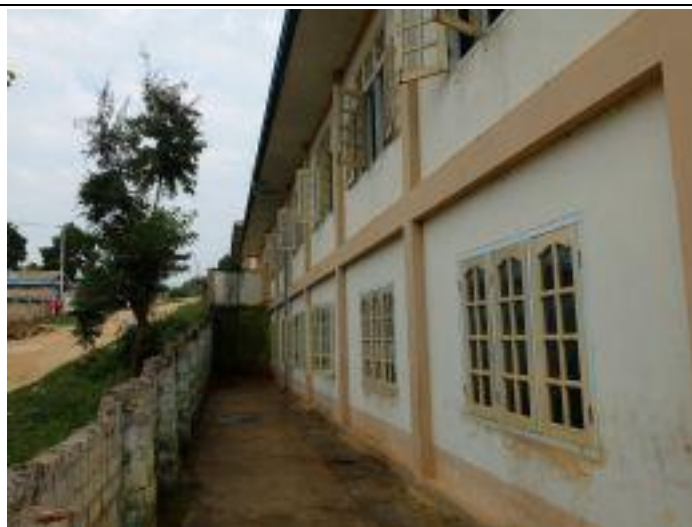
GGP で建設された校舎（後ろ側から）
