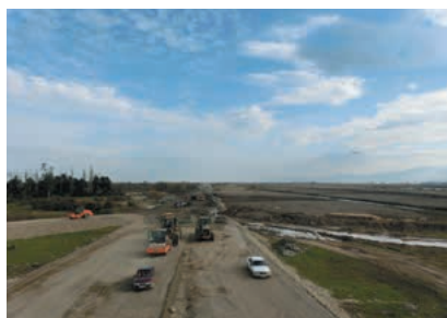
ジョージア「東西ハイウェイ整備計画」工事現場
