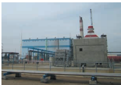
アゼルバイジャン「シマルガス・火力複合発電所第2号機建設計画」建設現場
