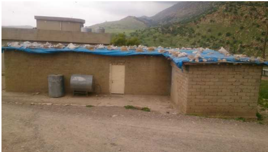
【改築工事後の新校舎】
