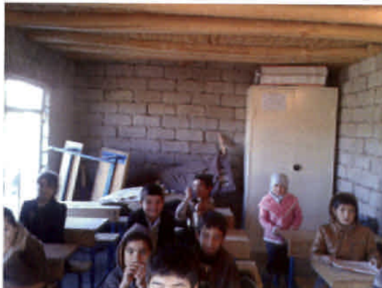
倉庫がないため、教室でストーブや灯油等を保管している
