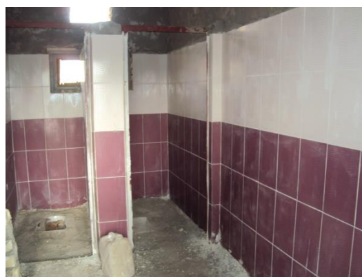
修復中のトイレ (Al Adil 校)
