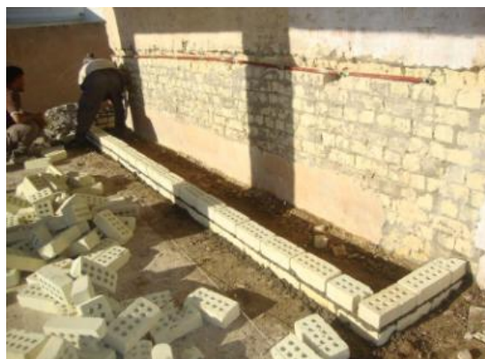
建設中の水飲み場 (Al Adil 校)
