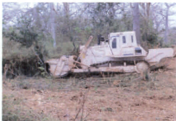
除去作業中の地雷除去機
