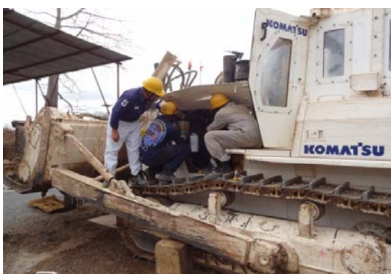
除去機整備作業を指導中の専門家
