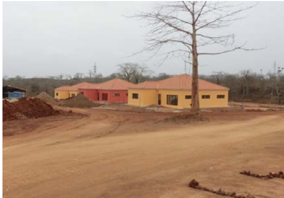
ベース沿いの新設・整備道路は日々 交通量が増加
