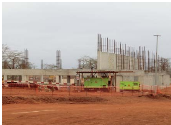
除去地には住宅及び体育館を建設中
