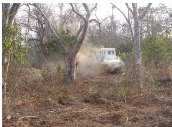
灌木の中を除去中の地雷除去機
