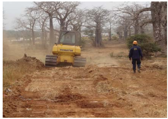
除去地への移動路の造成
