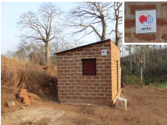
給水場管理室(壁にODAマークを貼付)
