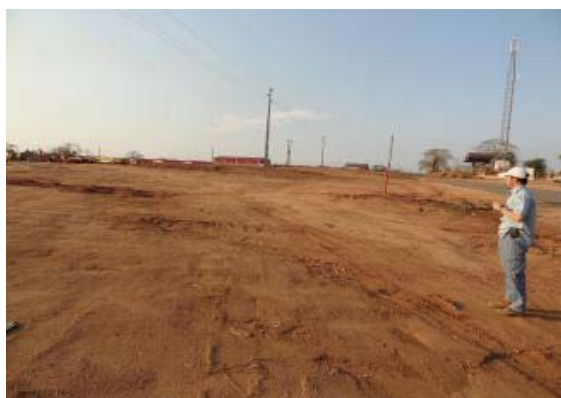
整地された除去地
