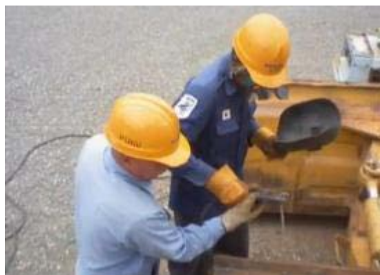
専門家の厳しい指導による溶接作業
