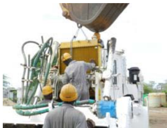
スタッフ全員での除去機改修作業
