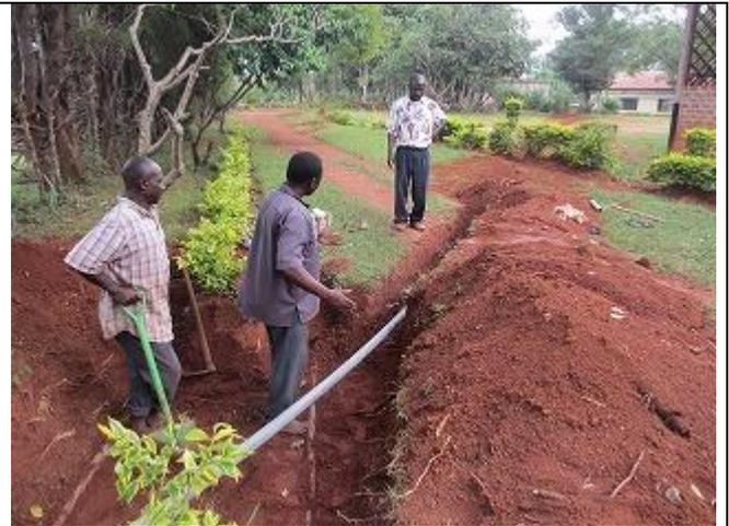
【写真 20】水道パイプラインの敷設。地元の配管工が作業を行い、約 1.0km の拡張を実施した。（2015年9月）
