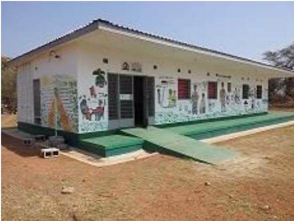
マタニティハウス完成風景
