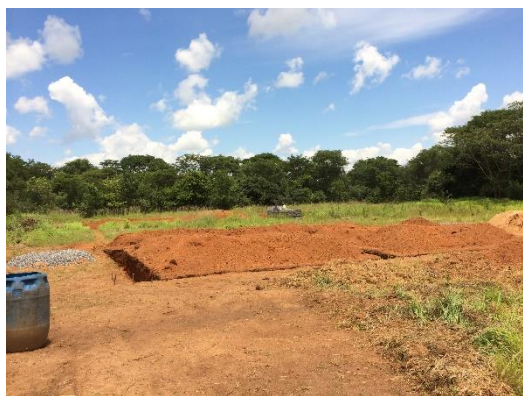
母子保健棟を建設中
