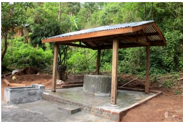
【活動 3-12】コミュニティにおける水衛生施設の設置・修復 ゼーコン村の住民が修復した浅井戸。ゼーコン村以外の 2 村においても浅井戸を建設している。
