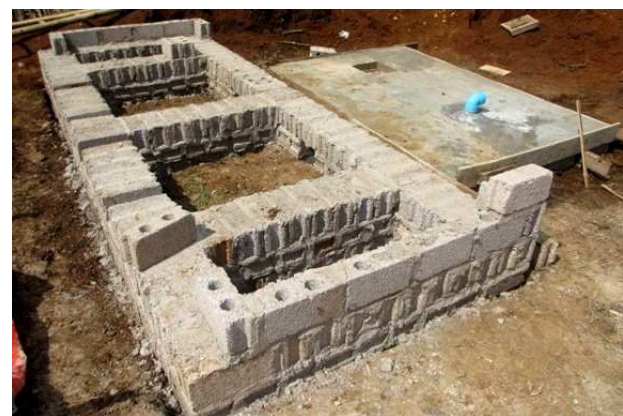
【活動 3-14】学校における水衛生施設の設置・修復 マイム村の住民が建設中の小学校用衛生施設(トイレ)。学校用貯水槽を 1 校、学校用衛生施設を 7 校で建設中である。
