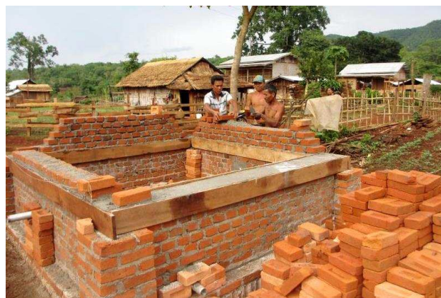
【活動 3-12】コミュニティにおける水衛生施設の設置・修復 チャウンサー村の住民が修復中の水供給施設(自然流下方式)。水へのアクセスが特に困難な 11 村で自然流下方式施設の設置・修復を行っている。
