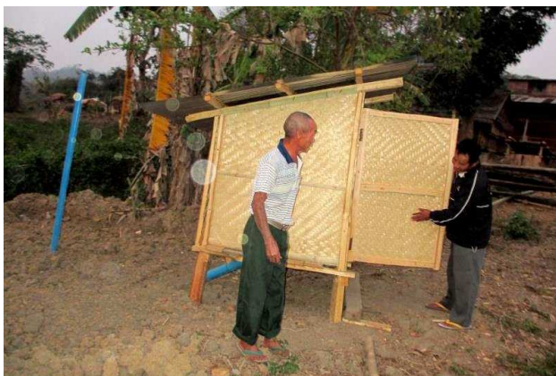
【活動 3-12】コミュニティにおける水衛生施設の設置・修復 ナンパイ村の住民が建設した共用衛生施設(トイレ)。各村のニーズに応じて計 376 基建設予定である。
