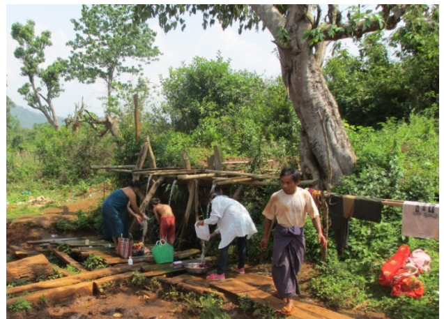
修復する飲料水供給施設（Chaung Sar 村）
