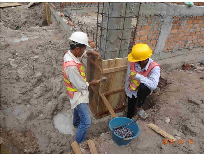
コンクリートを打設するための木枠を設置
