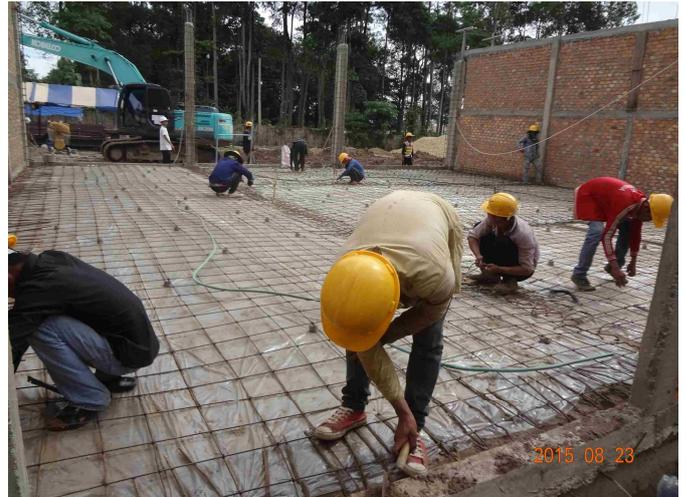
コンクリート打設前スペーサーを挟む作業員
