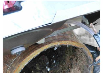
カット時の摩擦熱を下げるため水を掛けながらカットを行う
