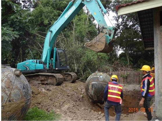
LCCが設置した排水タンクの位置が誤っていたため取り出し、再確認を実施
