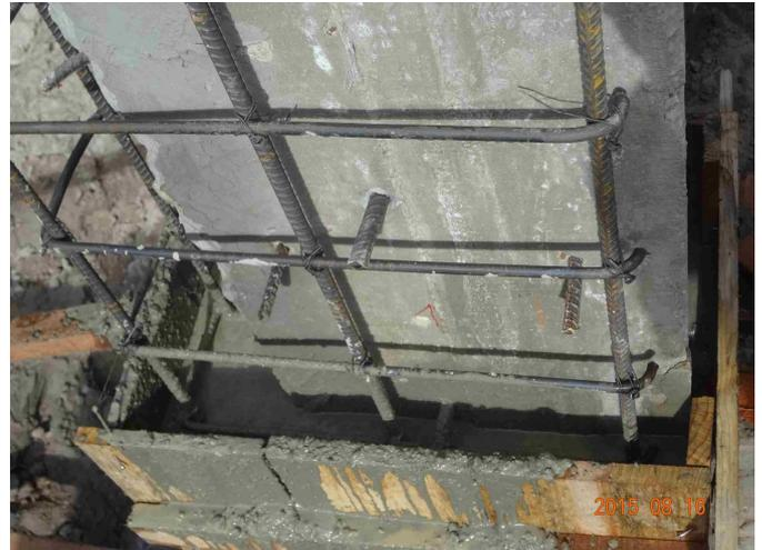
「200×400mm」の柱を「350×700mm」に補強
