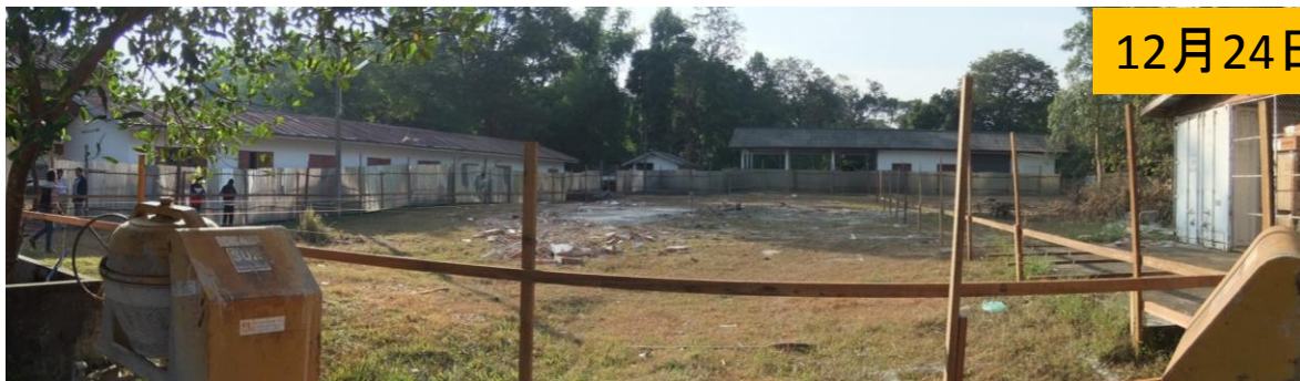
整地された教場建設地
