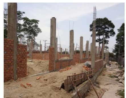
柱完成後に壁、「まぐさ」などの施工開始
