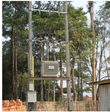
新設したトランスフォーマー
