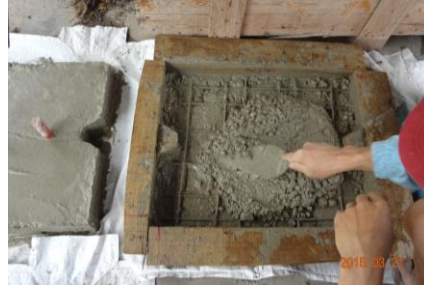
コンクリートの流し込み
