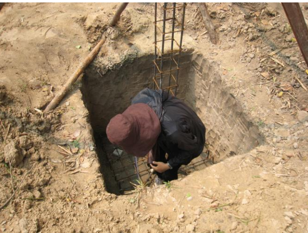
基礎穴の中で基礎鉄筋の確認を行うJMAS建築専門家補佐
