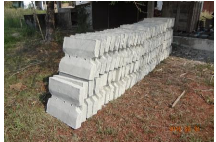
排水溝蓋の完成
