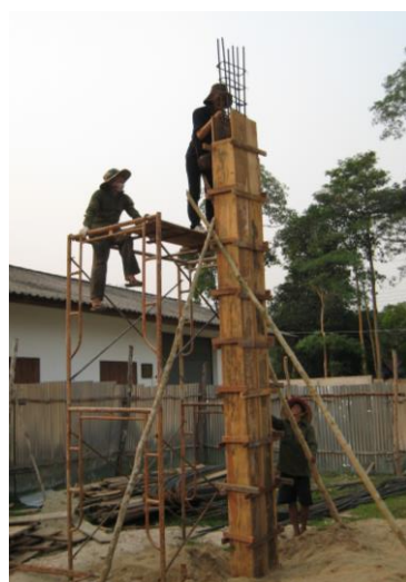
柱上部から鉄筋のかぶり厚さを確認するJMAS建築専門家補佐
