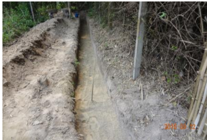
排水溝の溝堀
