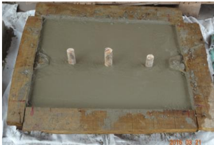
乾燥前の排水溝蓋
