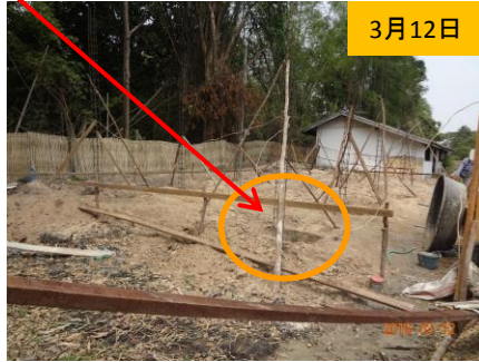
基礎穴掘り作業
