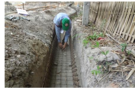
排水溝に基礎鉄筋とスペーサーを設置
