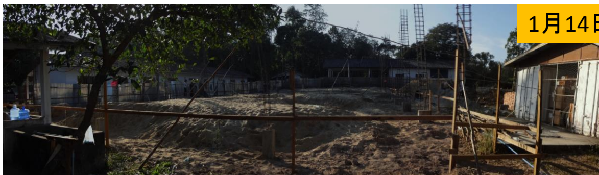
基礎の作成が終わり地中梁、柱の作成開始
