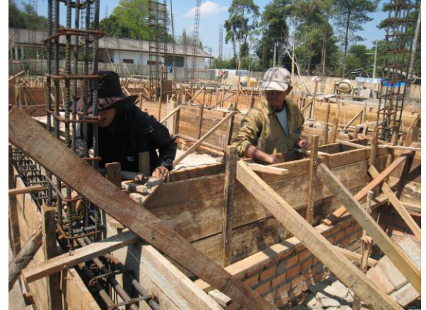
梁鉄筋及び柱鉄筋のかぶり厚さを確認するJMAS建築専門家補佐と作業員
