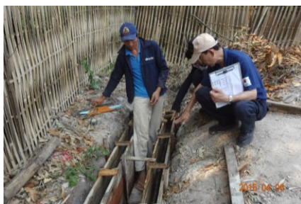
コンクリートを流す前の確認を行うJMAS建築専門家
