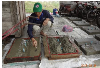
一つずつ丁寧にコンクリートを流し込む作業員
