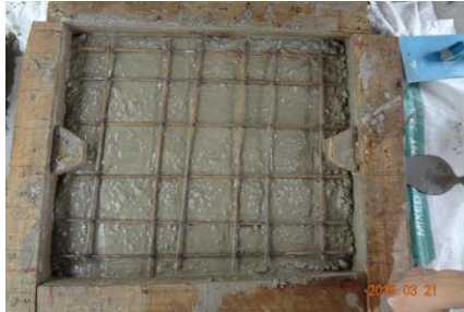
蓋の鉄筋と木枠
