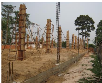
柱にコンクリートを流し込むための木枠設置
