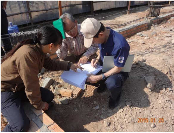
建築会社と現場確認を行うJMAS建築専門家
