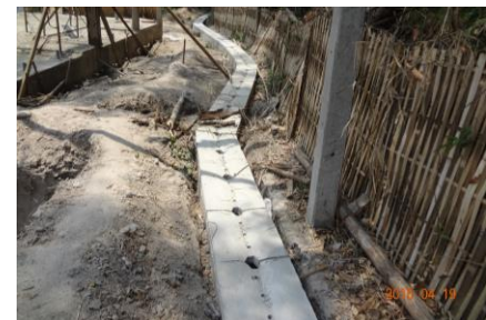
排水溝蓋の設置
