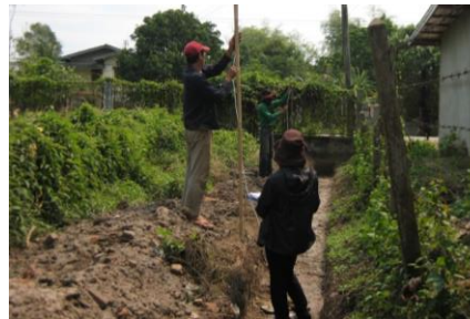
排水溝の傾斜確認を行う建築専門家補佐
