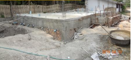
排水管の設置を行い床スラブの作成
