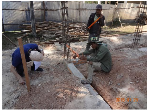
床レベルの確認を行うJMAS建築専門家
