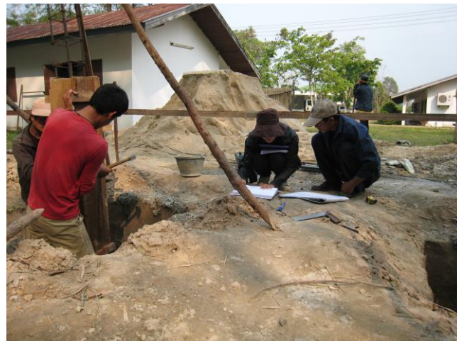
設計図面と施工状況を確認するJMAS建築専門家補佐
