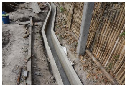
排水溝の完成
