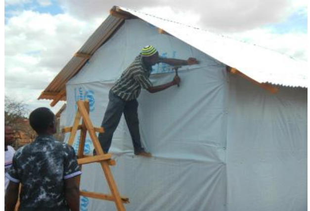
壁となるシートの取り付け
