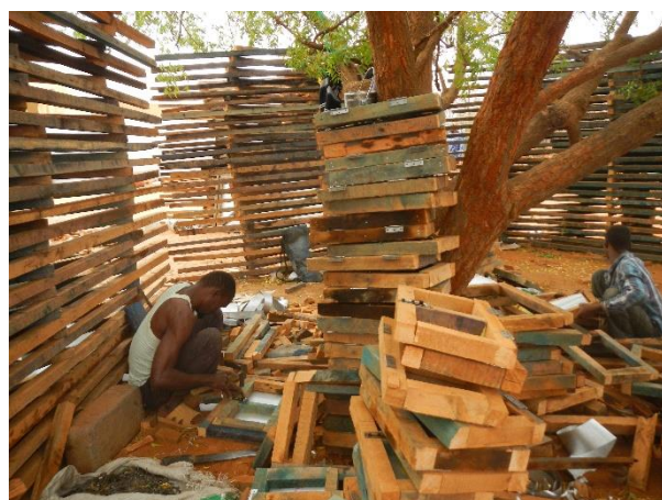
窓枠作成作業
