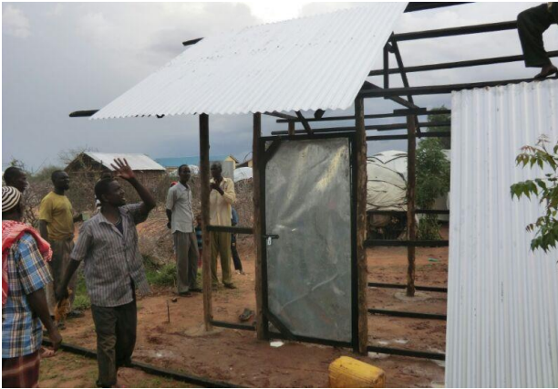
屋根の取り付け
