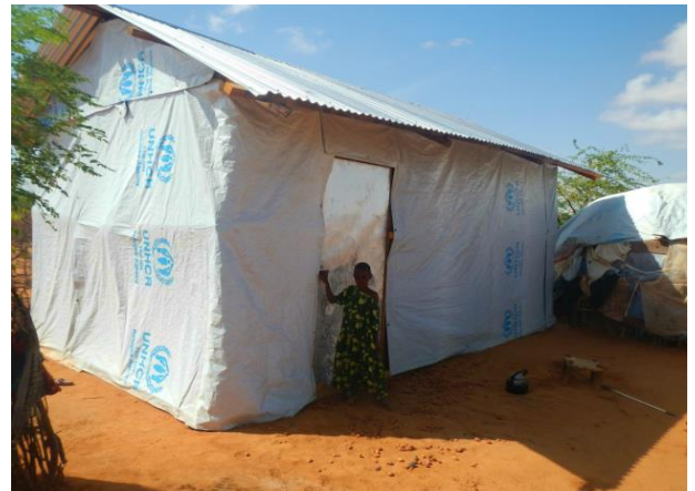
完成した仮設住宅外観
