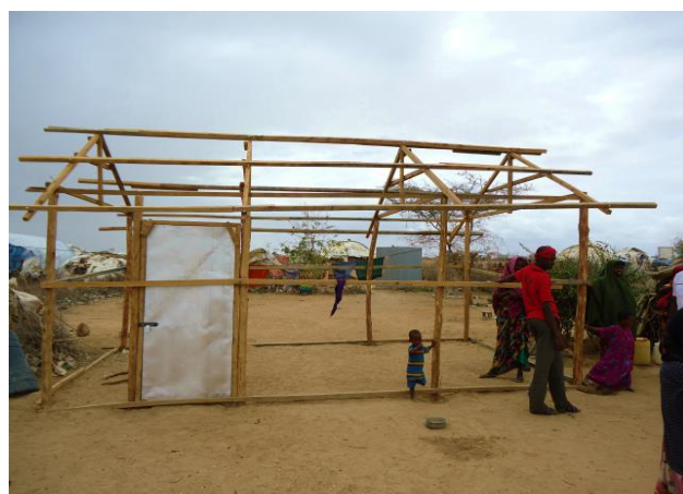
仮設住宅の骨組み
