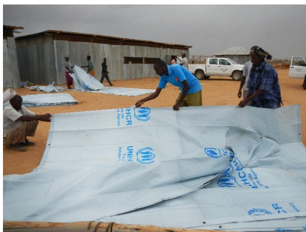
壁となるシートの裁断作業
