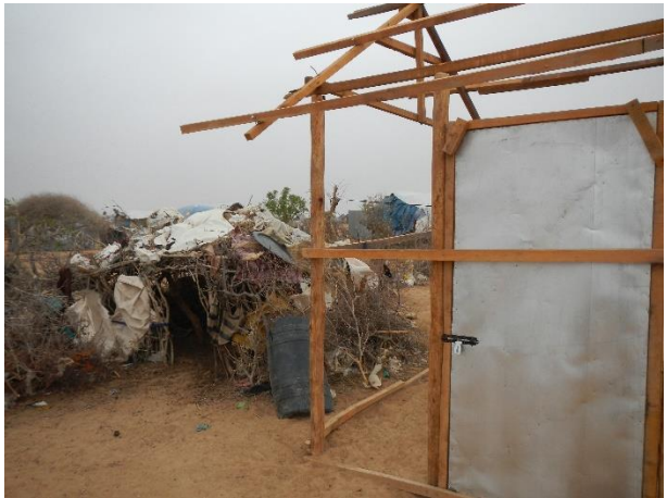
古い小屋の横で建設中の T シェルター
