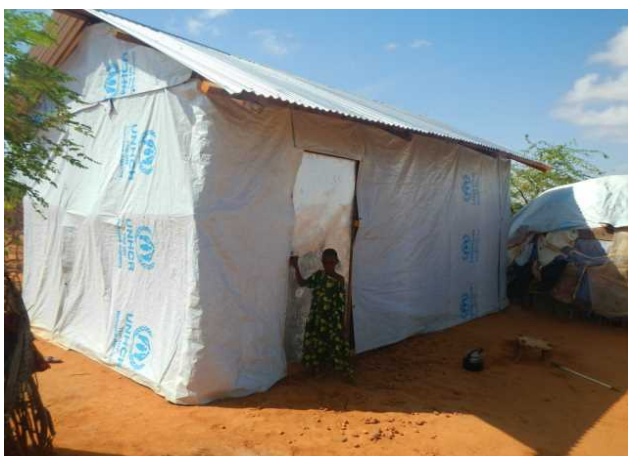
11. 完成したシェルター。
