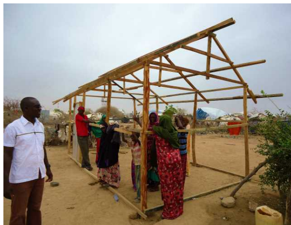
6. 骨組みの様子（その1）
