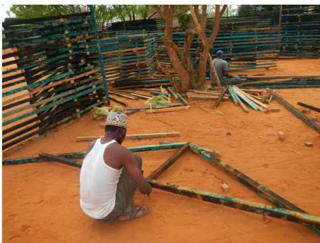
3. 屋根の枠作り。
