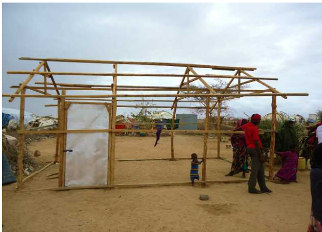
7. 骨組みの様子（その2）
