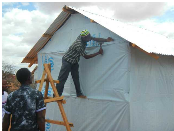
8. プラスティックシートを貼り付けている。
