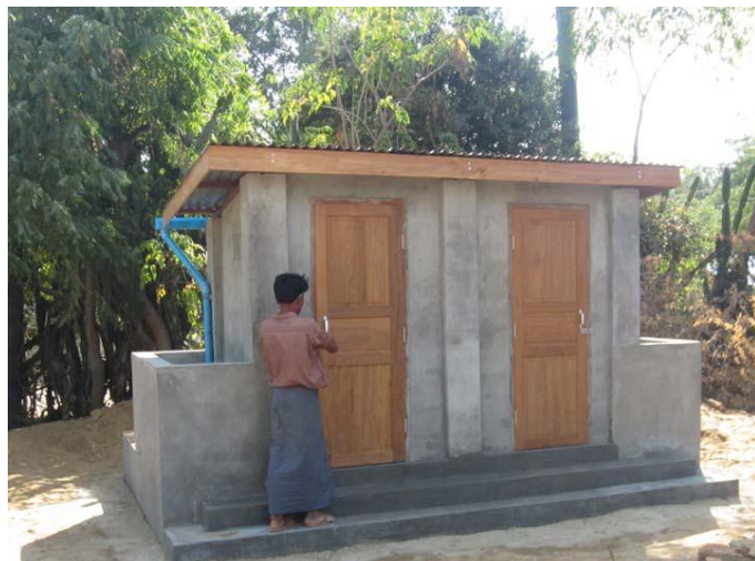
建設された学校トイレ (Myin Sa Kaw 村)
