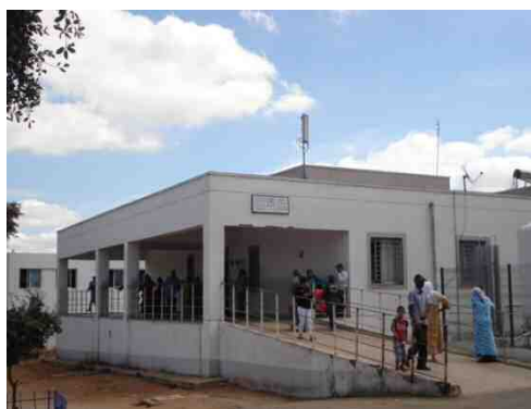
写真 4 エル・イドリシ州総合病院の外観 (撮影: 評価チーム)
