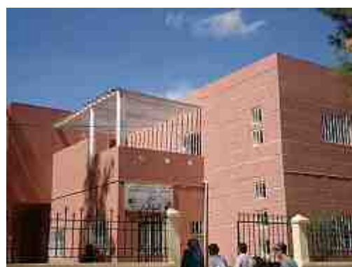
写真 14 日本の支援で建設された看板の掲示された
